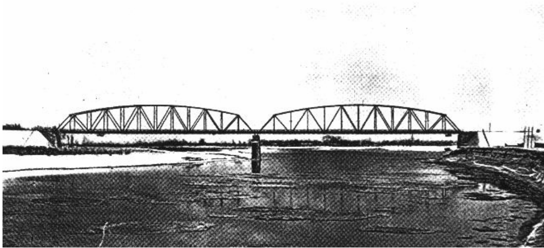
Ábra A balsai Tisza-híd
